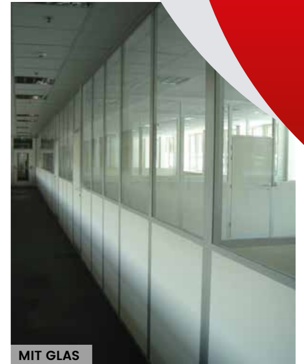
REINRAUM-WÄNDE UND -DECKEN
